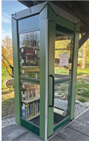
beschädigt waren und eine gründliche Aufbereitung erforderten. Zudem musste das Dach entsprechend neu abgedichtet werden, so dass die zukünftigen Bücher vor Beschädigungen geschützt sind. Nach der Beseitigung des Wasserschadens wurde die Telefonzelle einmal abgeschliffen, neu grundiert und mit dem Anbringen der Regalböden auf ihre neue Bestimmung vorbereitet.
