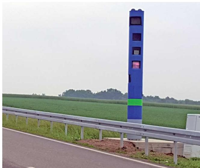
Ab dem 1. Juli 2018 wird auf allen deutschen Bundesstraßen die Lkw-Maut erhoben und mit Hilfe der Kontrollsäulen überwacht. Bundesweit werden/wurden hierzu etwa 600 Säulen errichtet, welche vorbeifahrende Laster erfassen.
