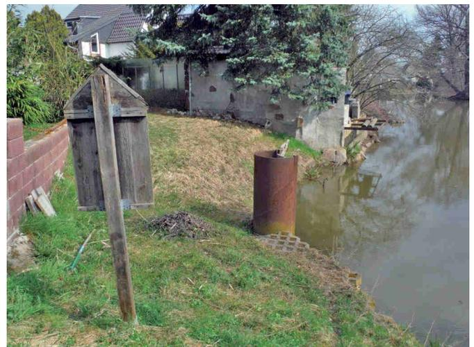
Im Rahmen der Hochwasserschadensbeseitigung soll der Teichmönch einschließlich der Überlaufleitung bis zum nächsten Schacht erneuert werden.
