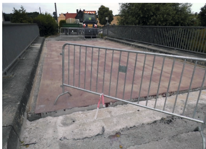
Während der Arbeiten
