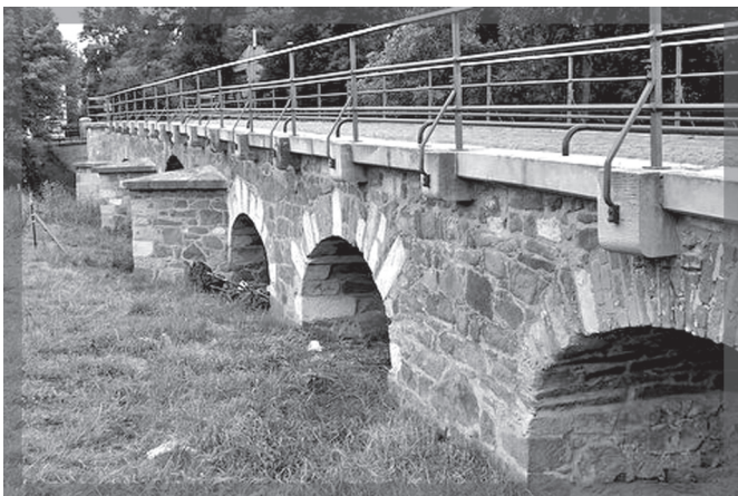
Die alte Pleißenbrücke in Paditz
