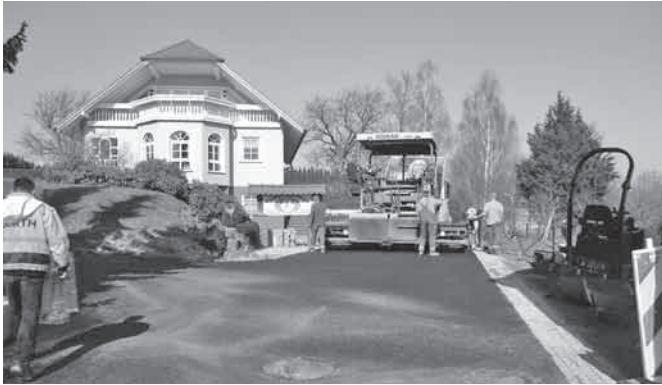
18. März 2015, 18 °C – Einbau Asphalt in Taupadel
