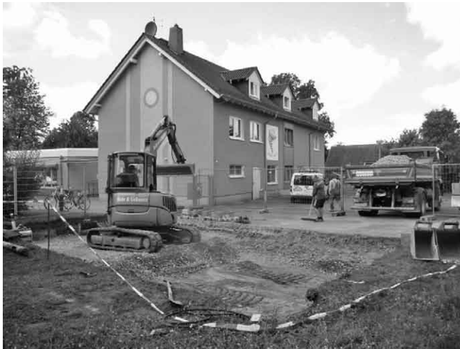
Parkplatzerweiterung an der Kita „Wirbelwind“
