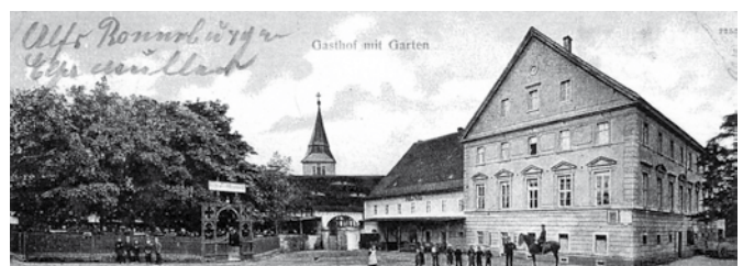
An dieser Ansicht von der Straßenseite aus gesehen, hat sich bis heute im Wesentlichen nichts geändert. Ausschnitt von einer alten Postkarte etwa um 1910
