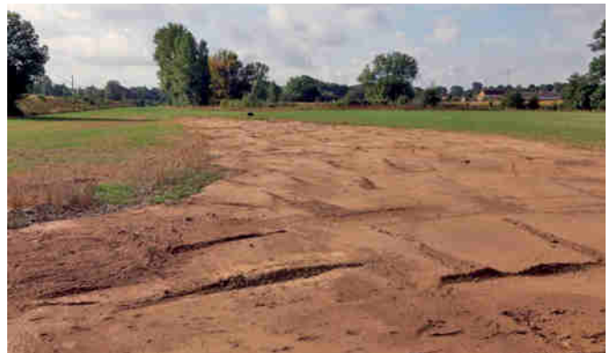
Trasse nach Fertigstellung
