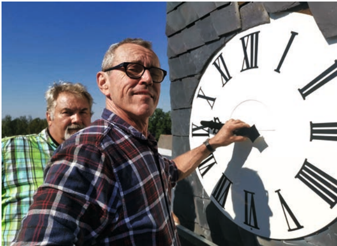
Uhren- und Glockenbauer Volkmar Knapp (r.) und Dachdecker Claus Franke (l.) übernehmen das Anbringen des neuen Zifferblattes nebst Zeigern. © Ilka Jost
