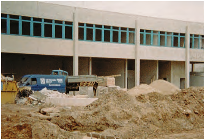
Rohbau des Einkaufszentrums
